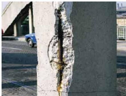
Prima di arrivare alla totale carbonatazione si passa gradualmente verso valori intermedi (con i primi fenomeni di arrugginimento) con variazione del pH che passa dal 12,5 a 10 e quindi via via all'8 con depassivazione del ferro d'armatura.
